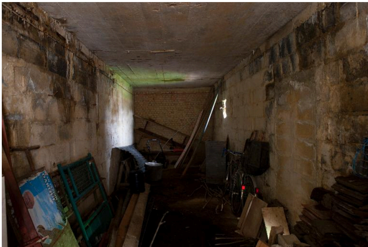
Bâtiment de stockage d'attente. Vue intérieure.
