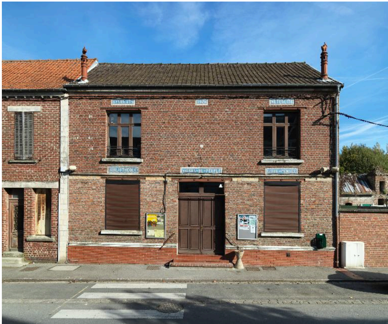
L'ancienne maison du peuple, rue de la République (ancienne chaussée Brunehaut).
