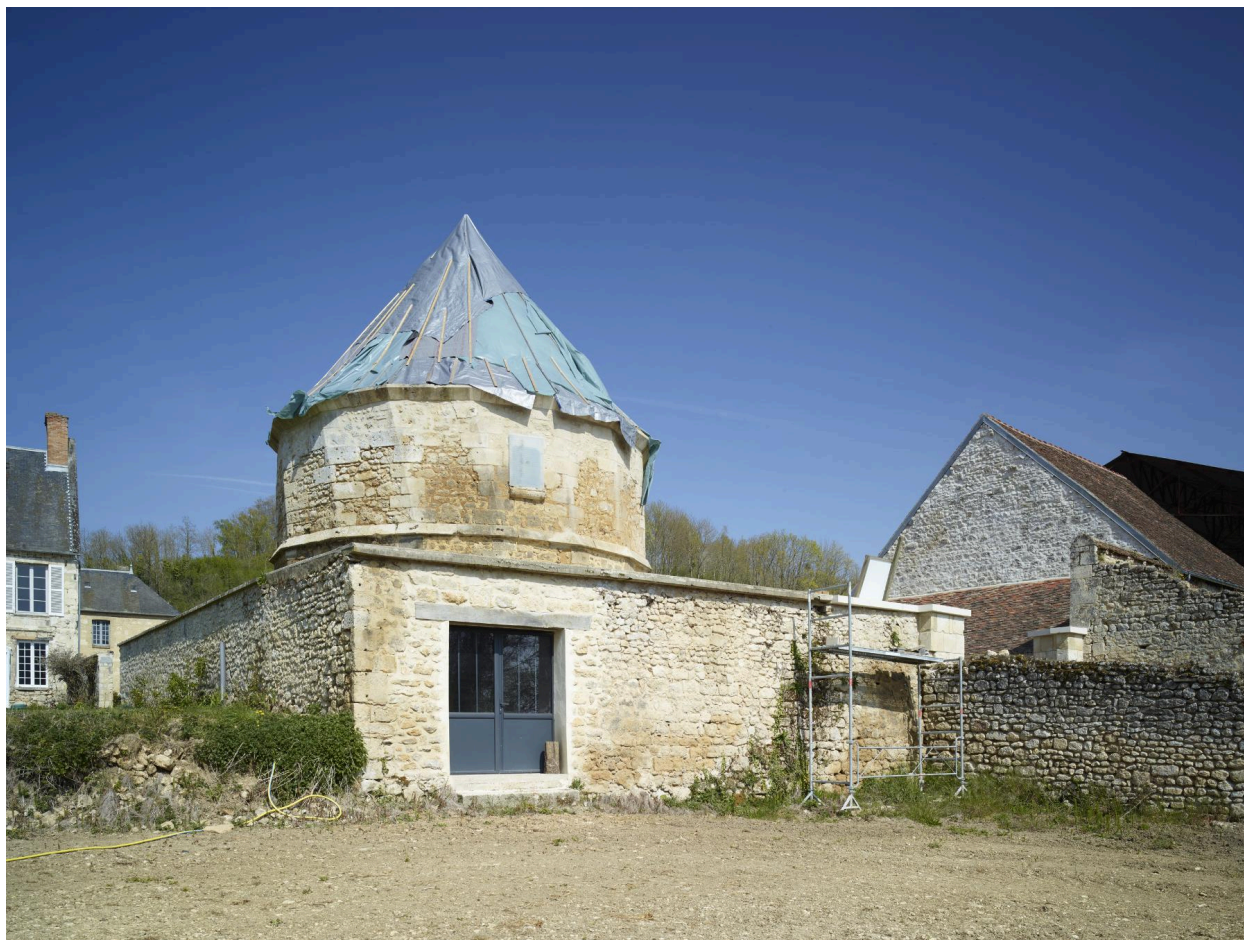
Vue générale du colombier prise depuis le sud.
