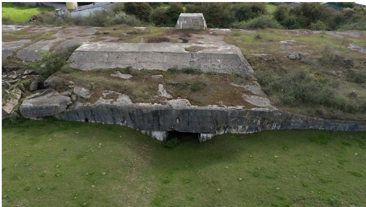
Vue aérienne de l'élévation nord-ouest. Détail de la sortie de la rampe de catapultage.
