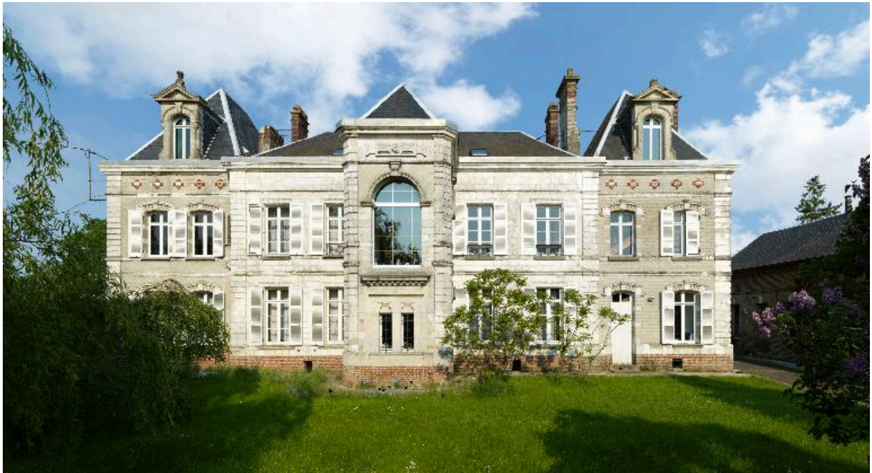
Façade postérieure, vue d'ensemble.
