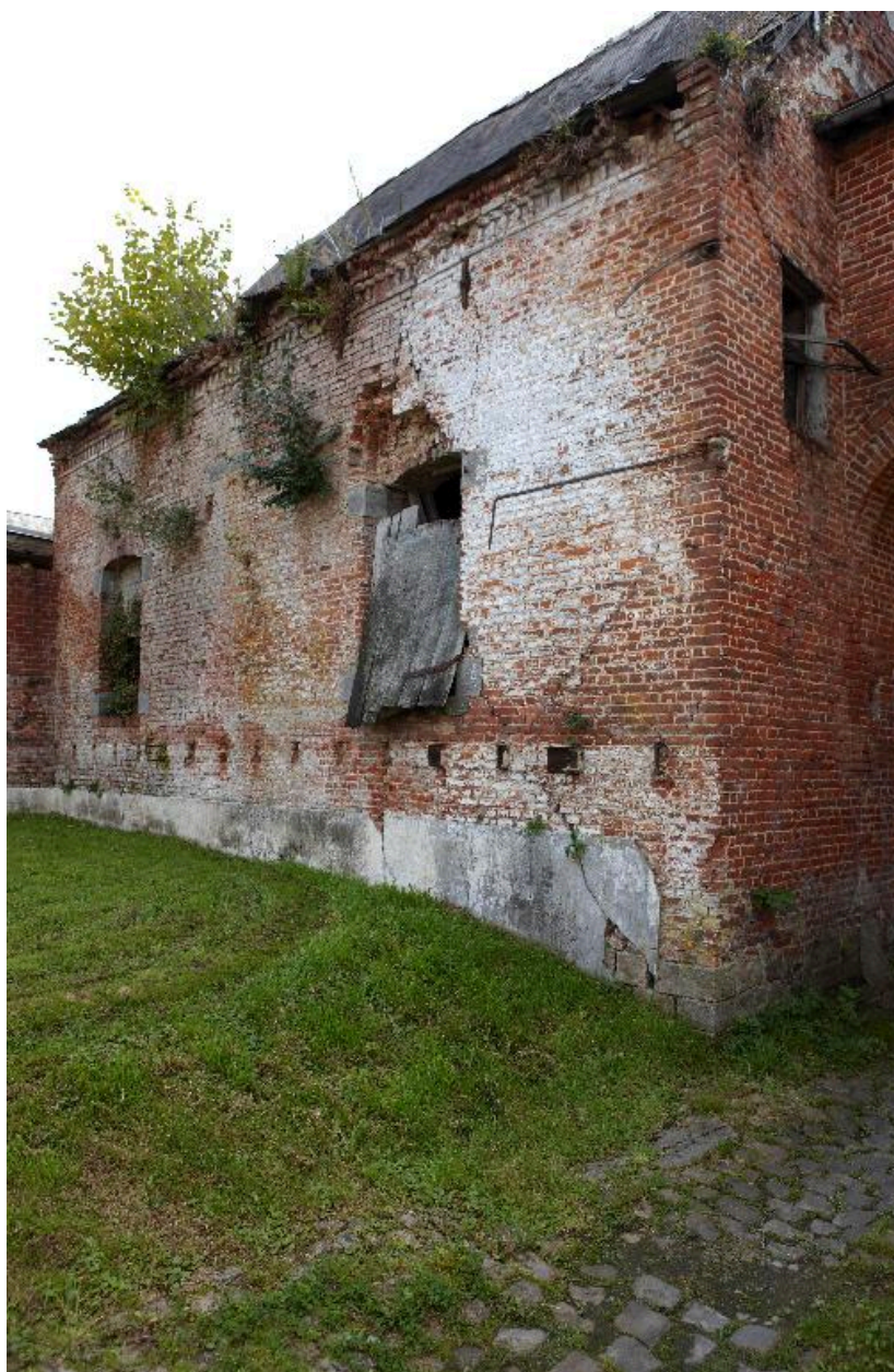
Elévation sur rue de l'ancienne salle des cuves.
