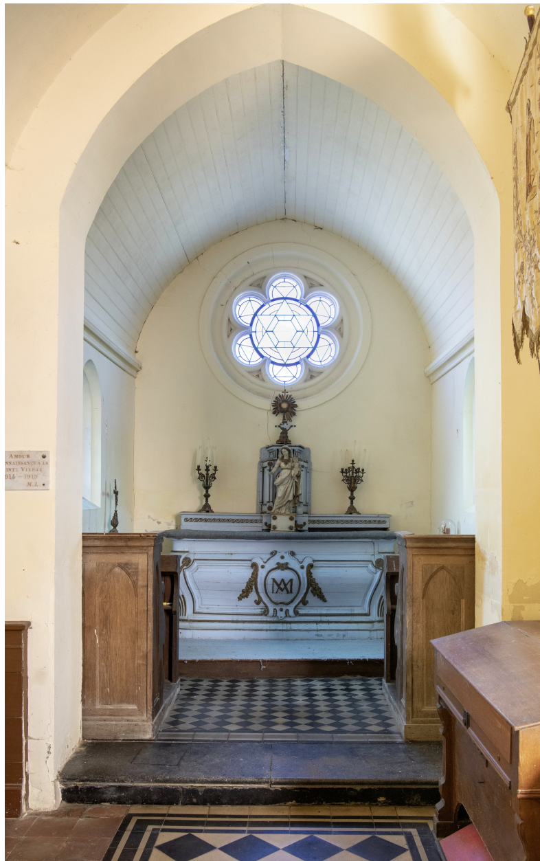
Vue générale de la chapelle de la Vierge.
