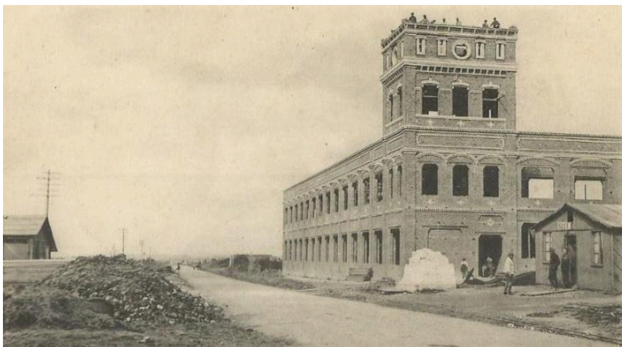
L'usine Tripette et Renaud en cours de construction, 1920 (Archives privées).
