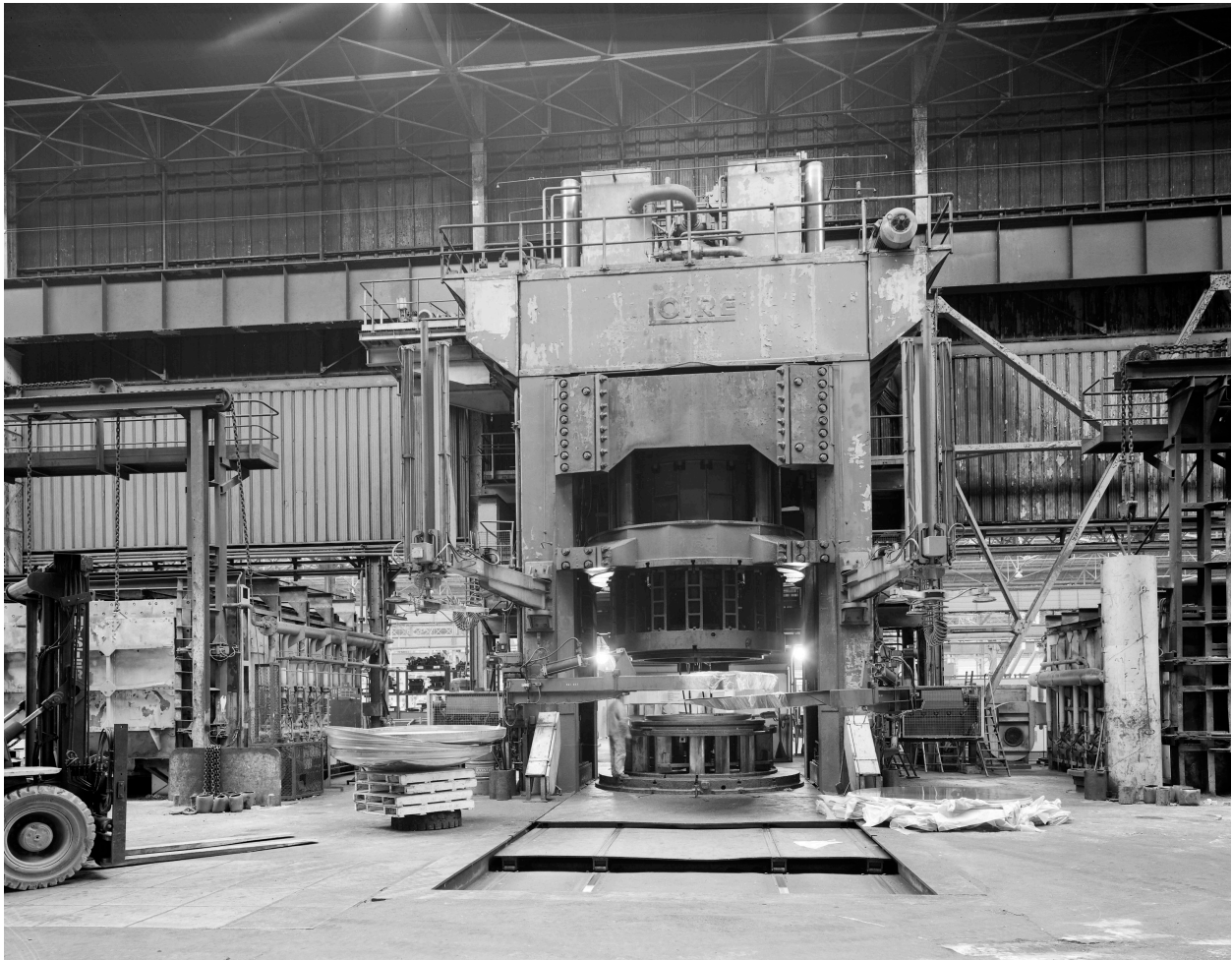
Hall 6 : vue générale de la presse Loire, 2 600 tonnes, emboutissant à froid et le four (à gauche).
