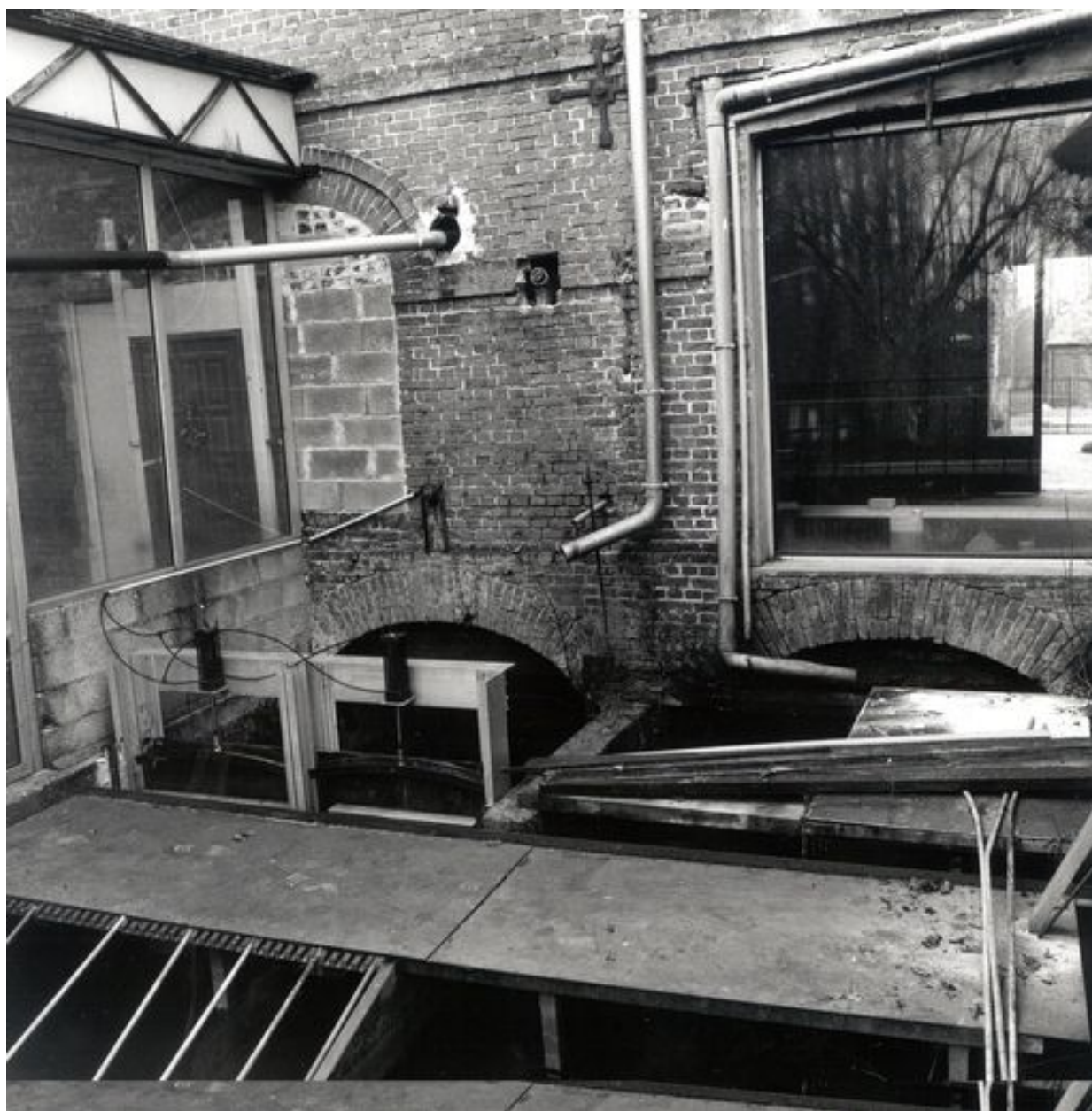
Détail de la double coulerie maçonnée.
