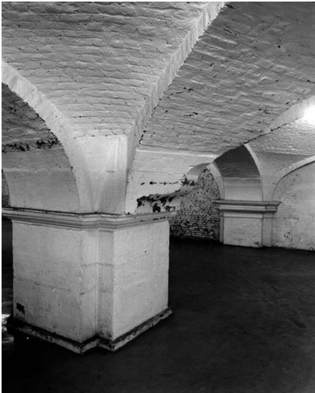
Corps de bâtiment fermant le fond de la cour d'honneur, sous-sol, salle à abside située au-dessous de la chapelle, détail d'un pilier et de la retombée des voûtes.
