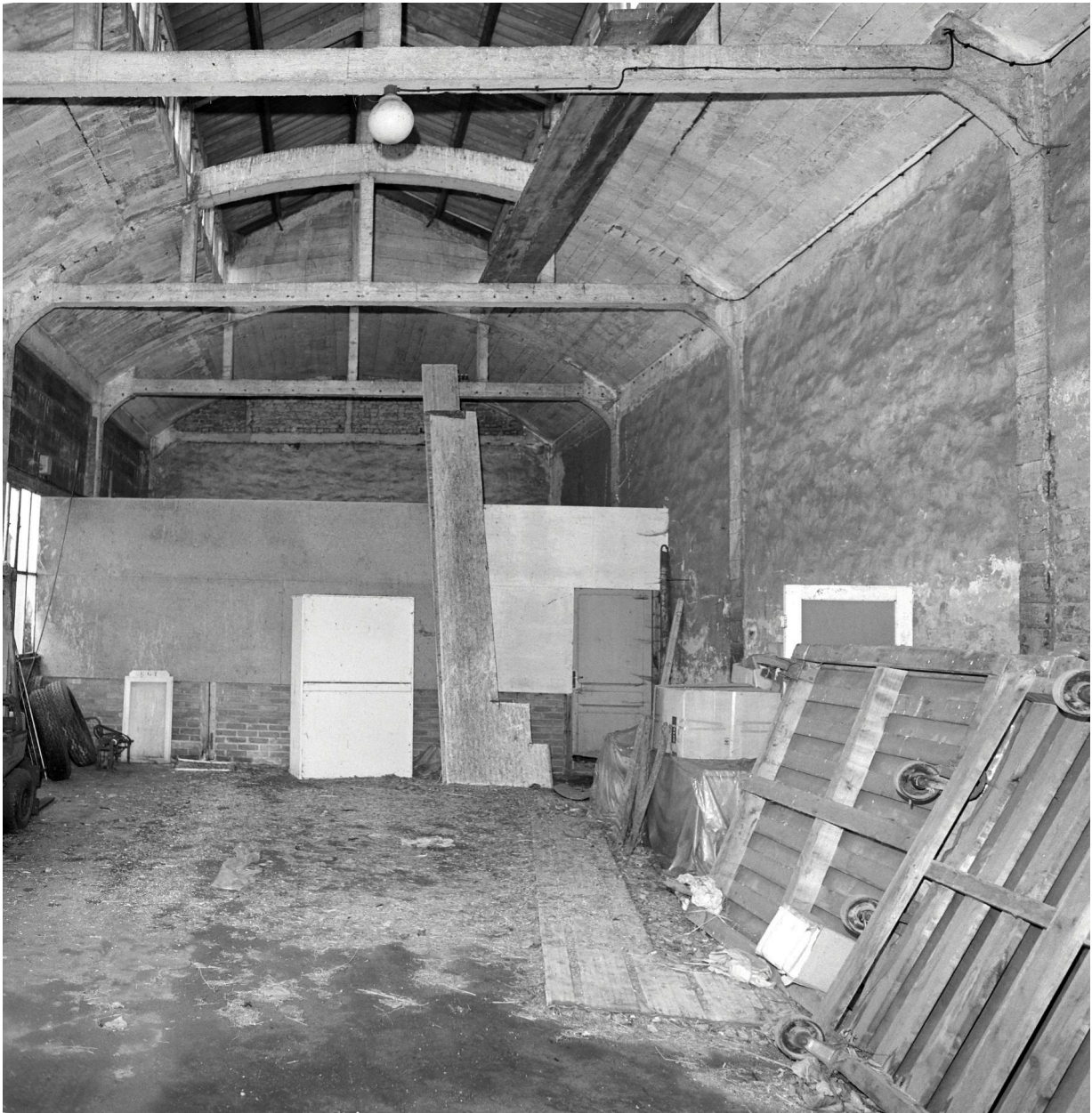
Vue intérieure du hangar.
