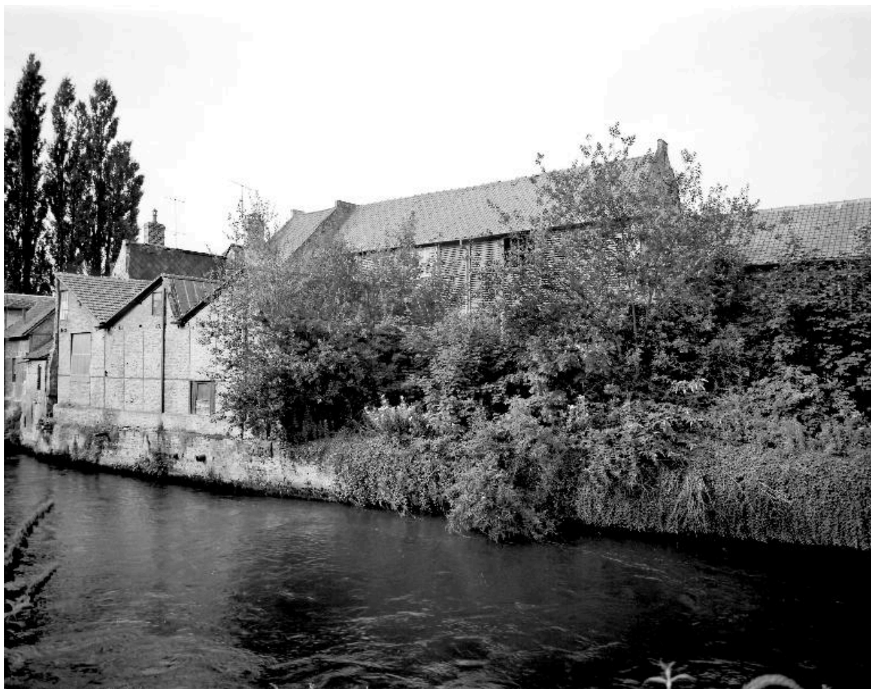
Vue générale, flanc est.
