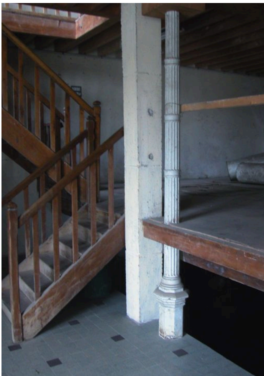
Détail d'une colonne cannelée en fonte, rez-de-chaussée.
