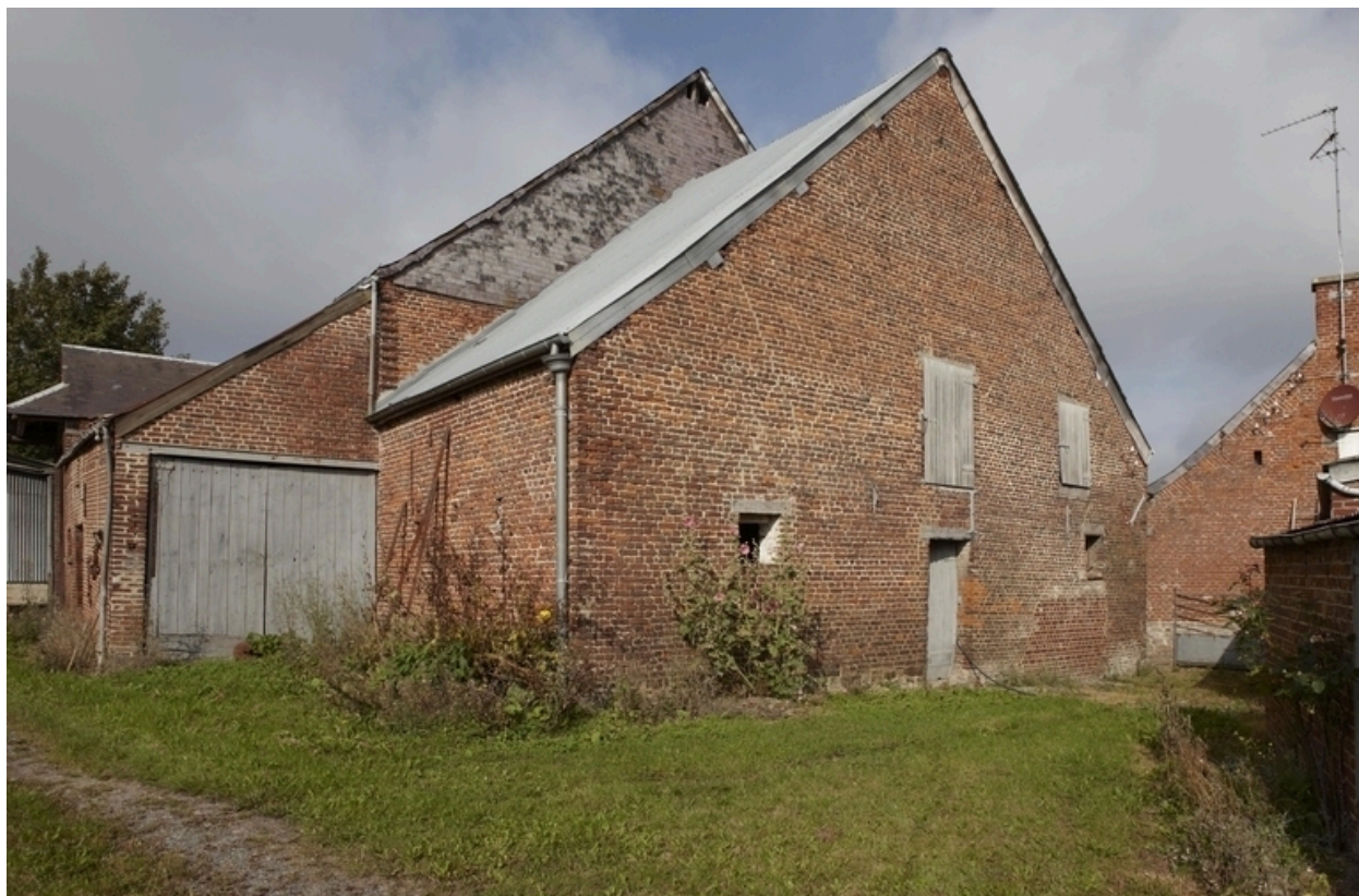
Vue des pignons de l'étable et de la grange.
