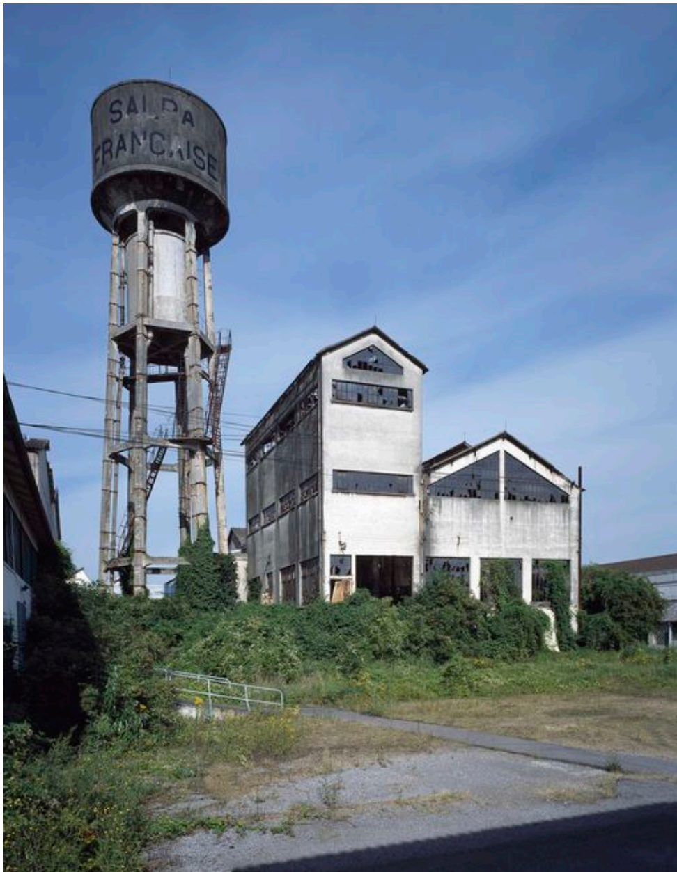
Château d'eau et centrale électrique.
