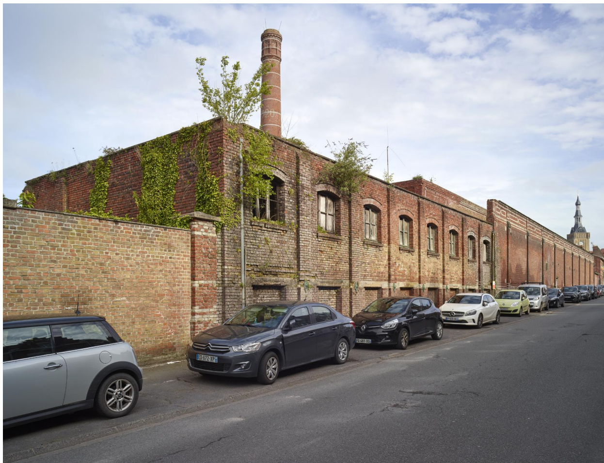
Vue depuis la rue du Général-Cheroutre, vers le nord : façades est du magasin industriel (premier plan) et du tissage.
