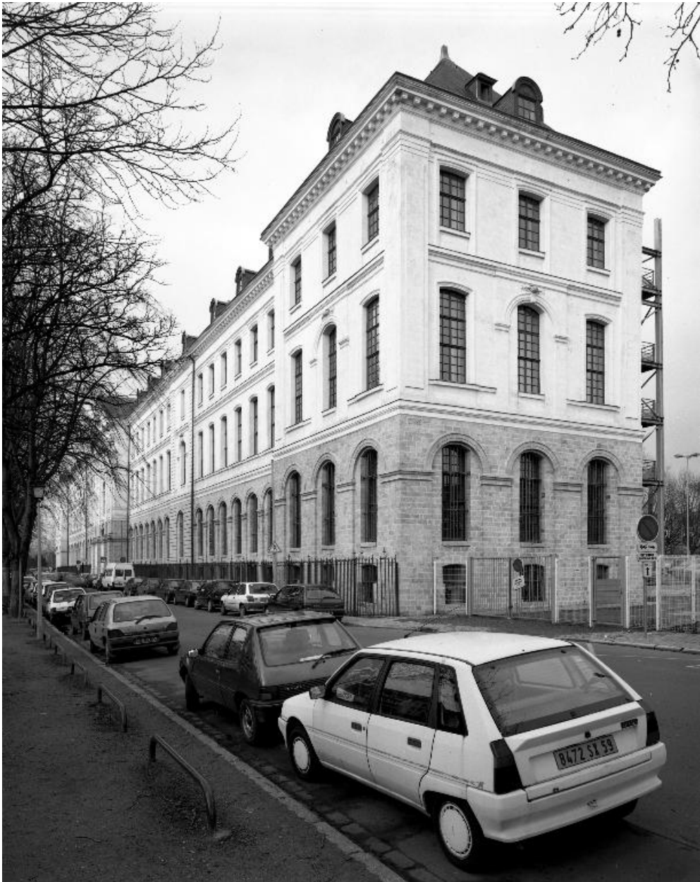
Bâtiment principal, élévation donnant sur l'avenue du Peuple-Belge, vue générale prise en enfilade depuis le flanc sud.
