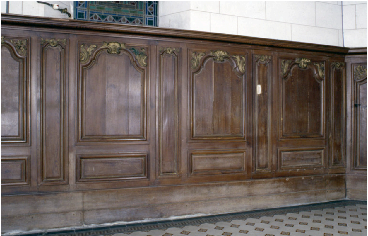
Vue partielle du lambris recouvrant le mur nord du choeur.
