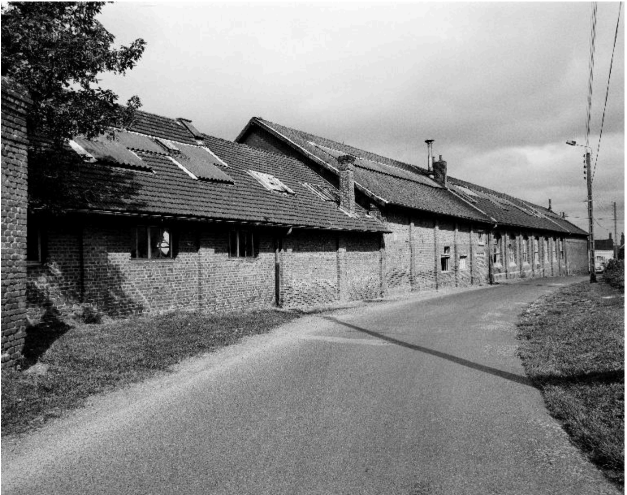
Atelier de fabrication est, vue d'ensemble.
