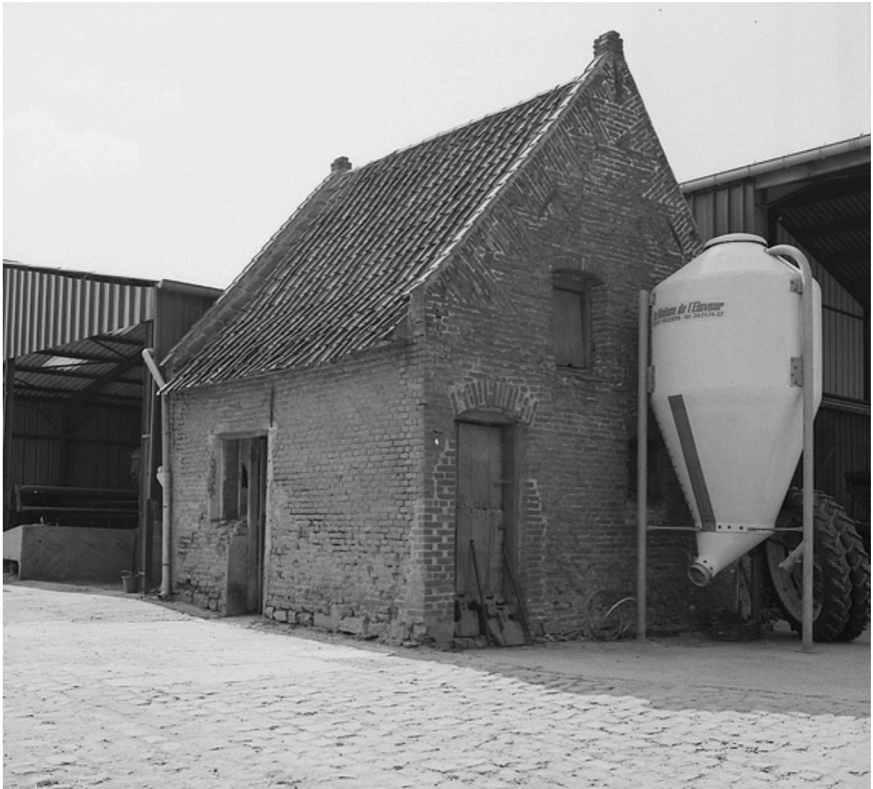
Vue générale du fournil.
