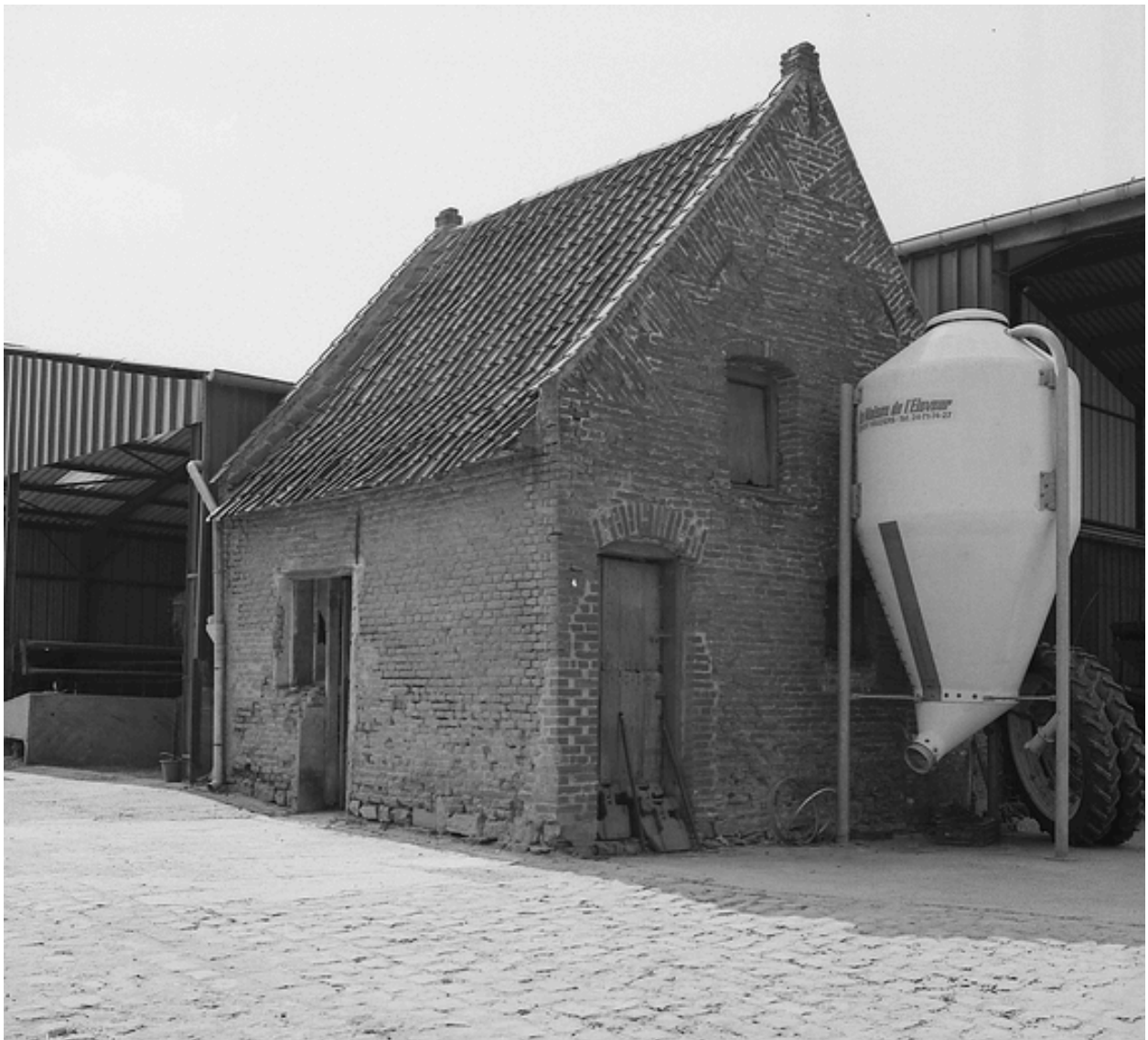
Vue générale du fournil.
