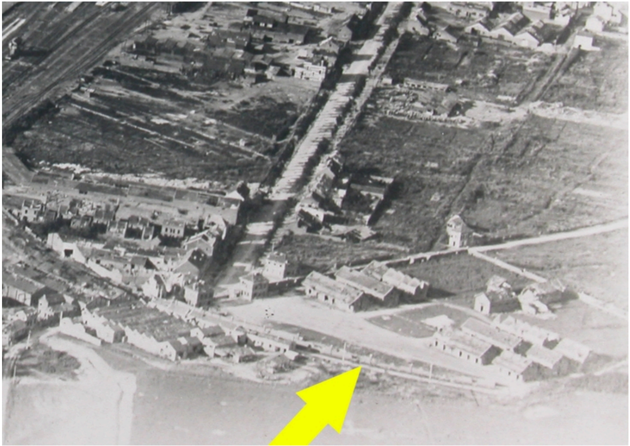
Vue aérienne de l'abattoir en juillet 1917 (BM Saint-Quentin).
