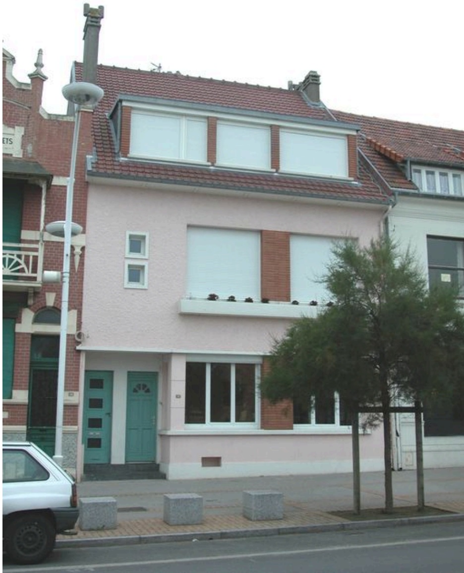
Maison à deux logements superposés (975 avenue de la Plage).
