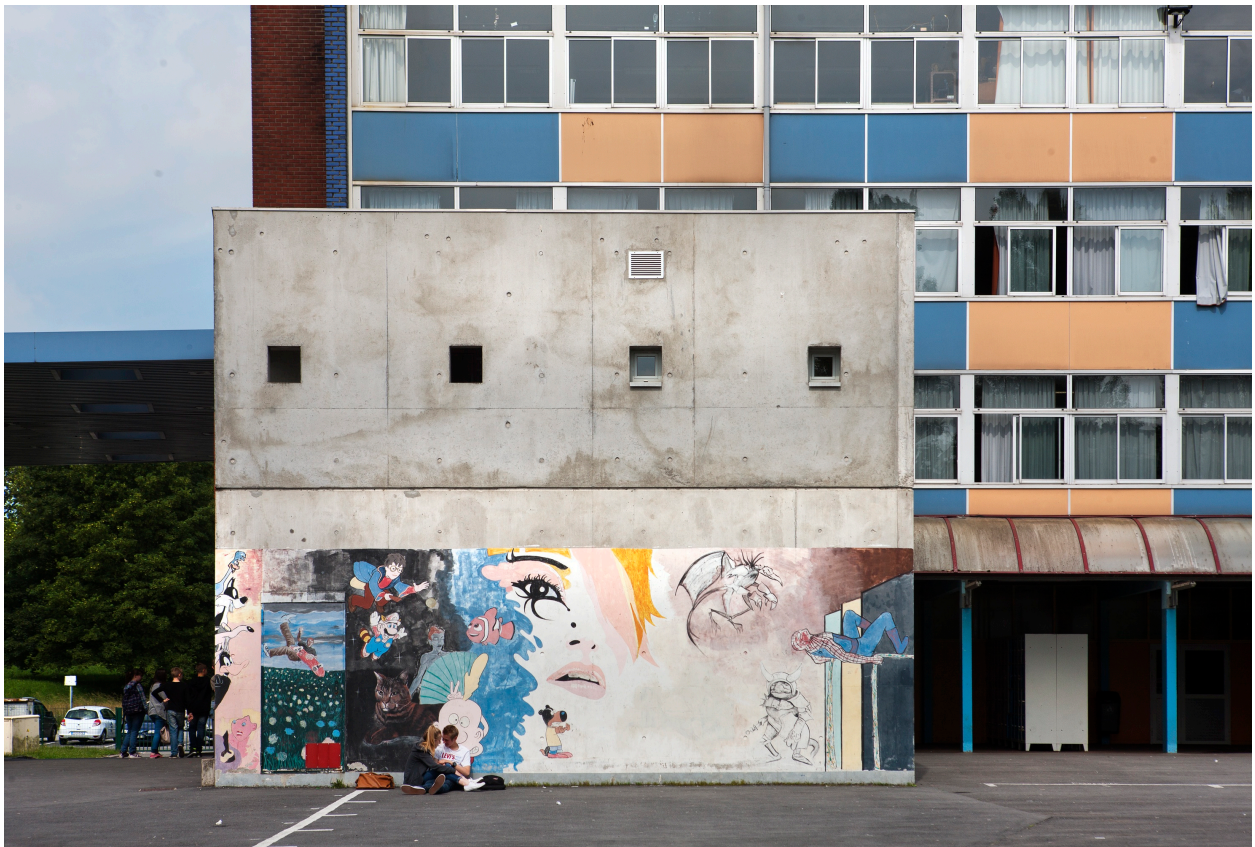
Centre de ressource de la SEGPA : façade est sur cour, 2016 (détruit en 2016).
