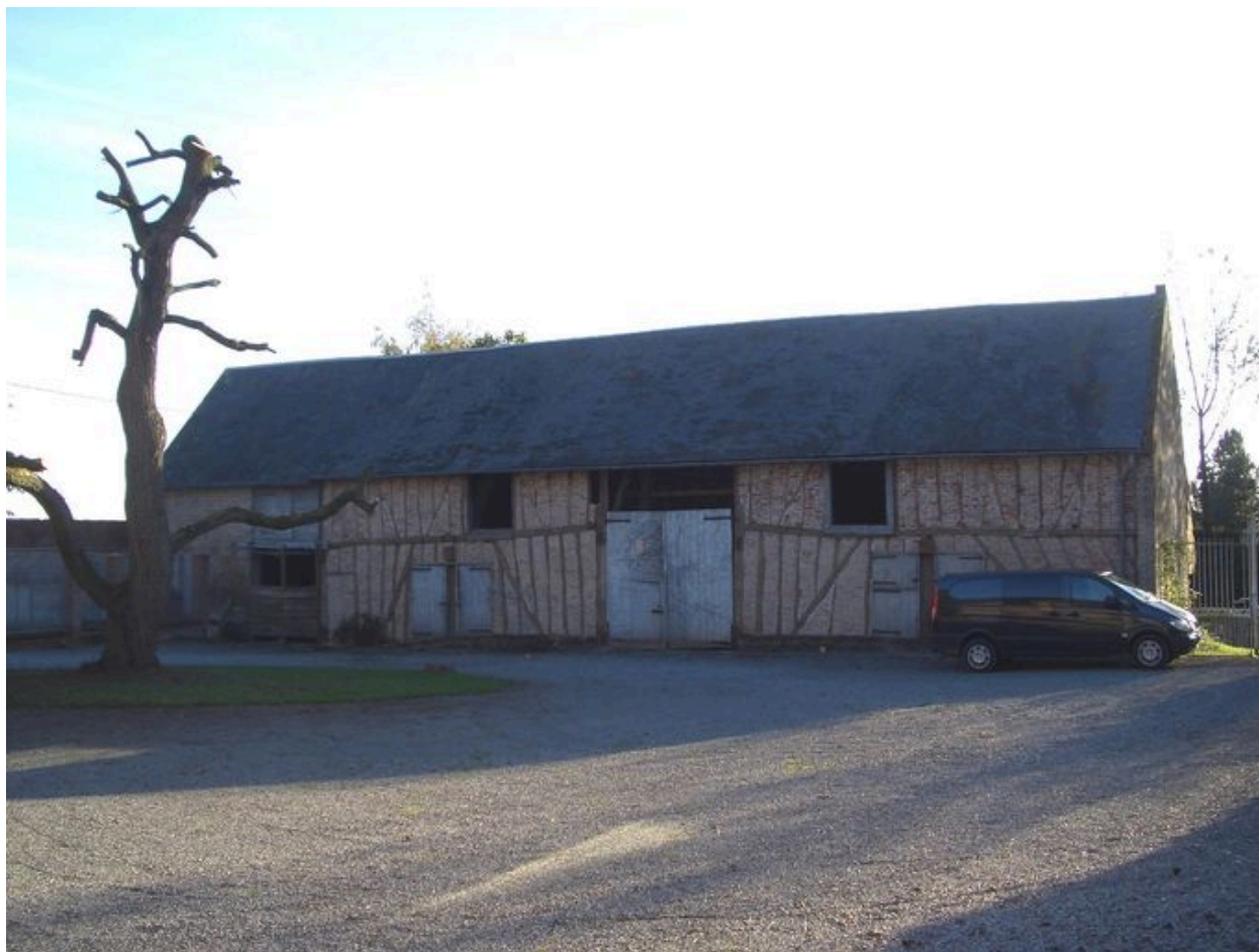
Vue de la grange au sud.
