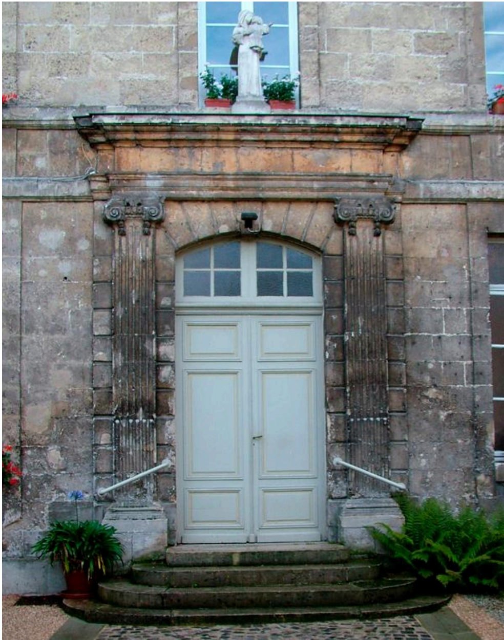
Vue de l'entrée du logis prieural, sur la cour.
