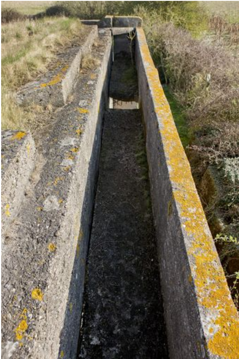
La tranchée surélevée, vue plongeante vers l'est
