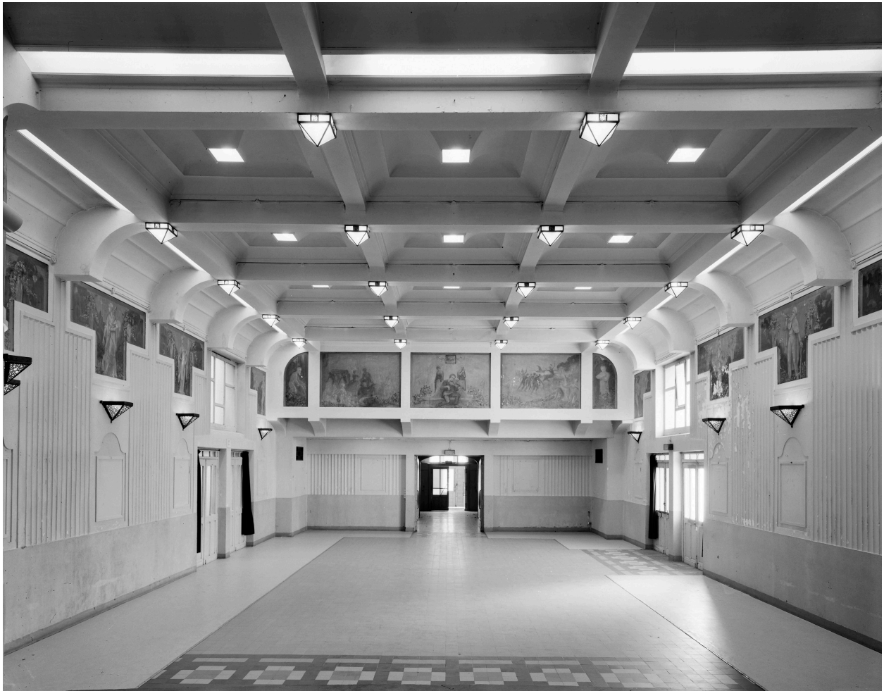
Vue générale de la salle de musique, vers l'entrée (rez-de-chaussée).
