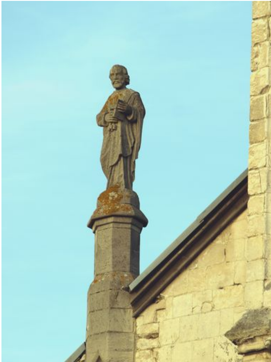
Saint Pierre : vue d'ensemble de trois-quarts
