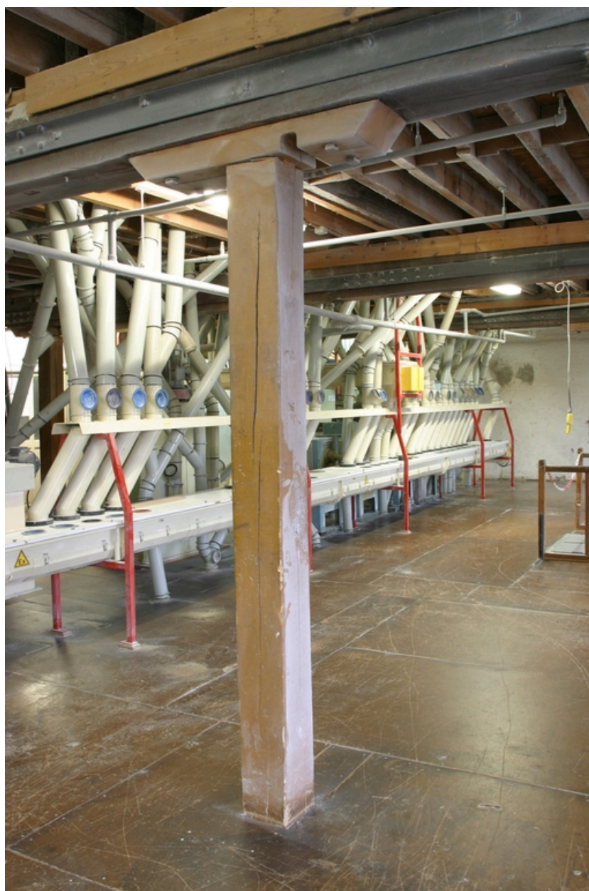
Troisième étage de la minoterie.
