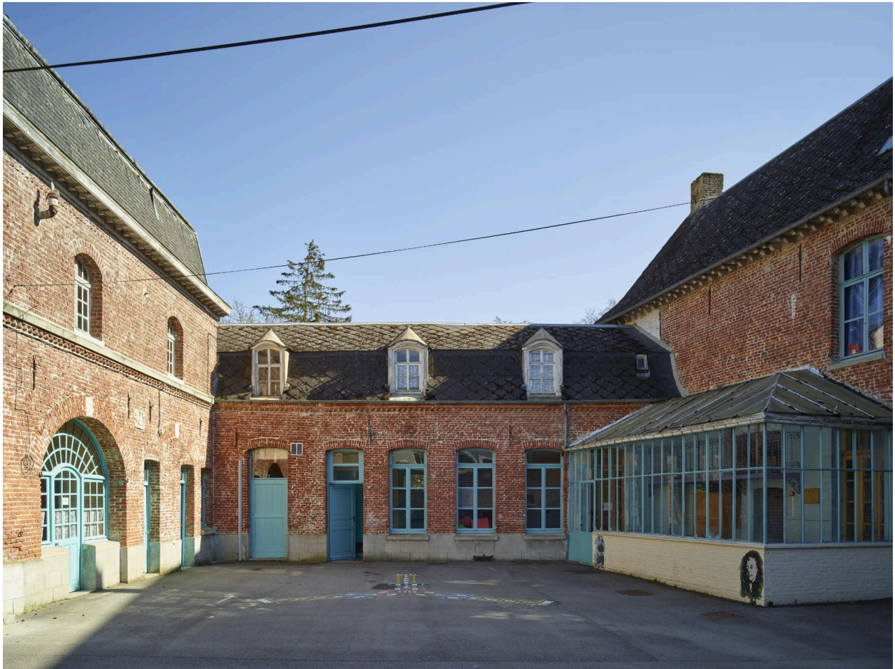
Vue de la façade arrière de l'aile sur la rue Chevray, depuis la cour de l'école primaire Chevray. Vue orientée nord-ouest/sud-est.
