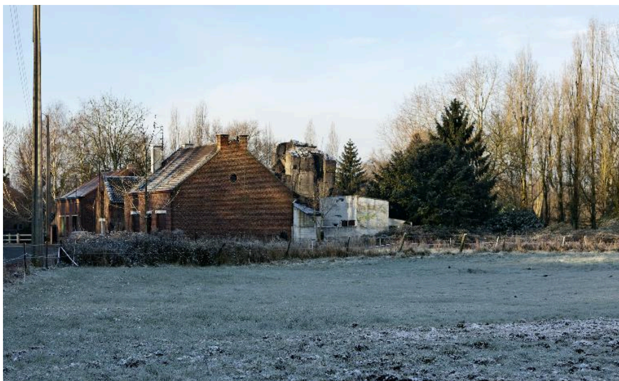
vue générale vers vers le sud
