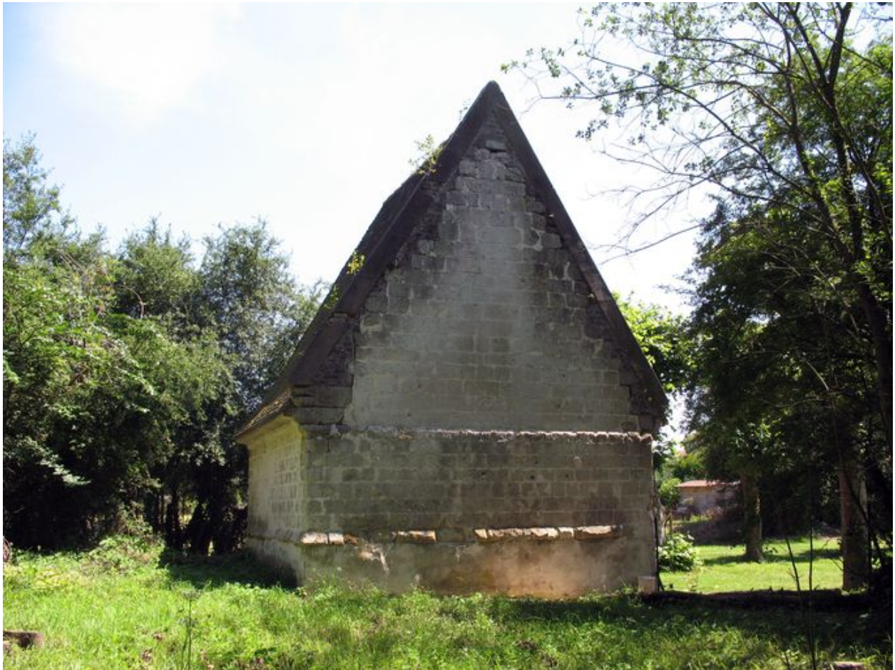
Vue du pignon ouest.
