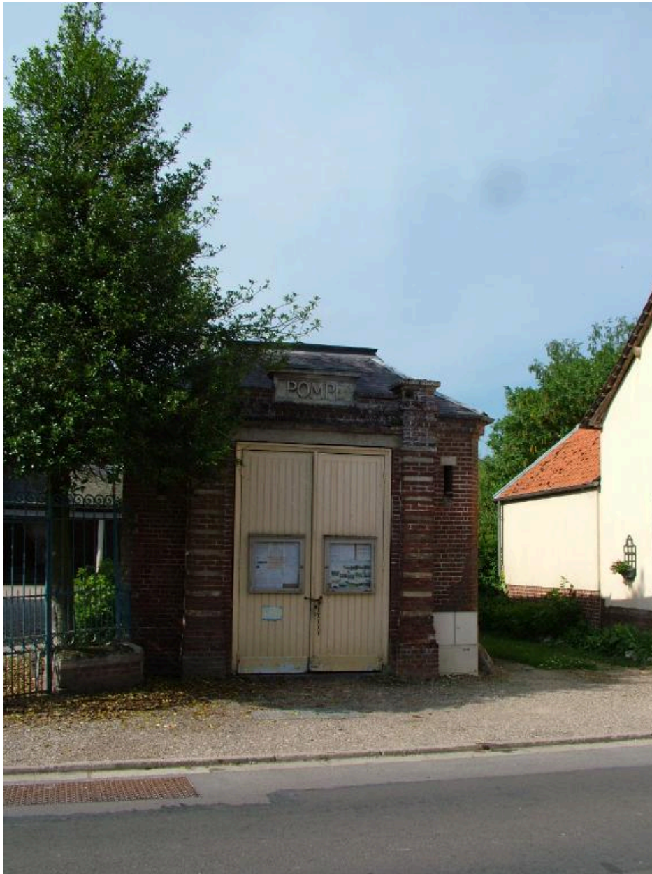
La remise de la pompe à incendie.
