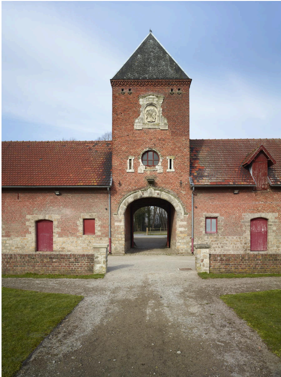
Détail de la tour porche depuis la cour intérieure
