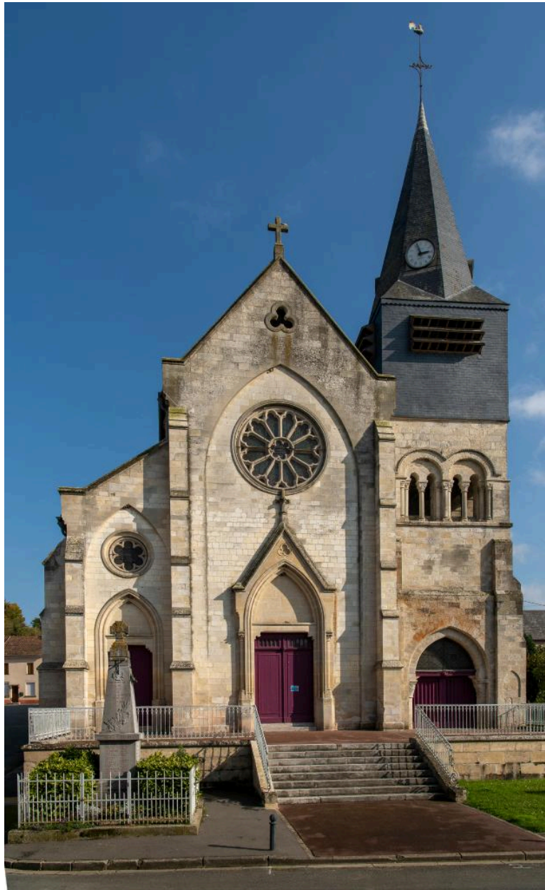
Vue générale de la façade occidentale.
