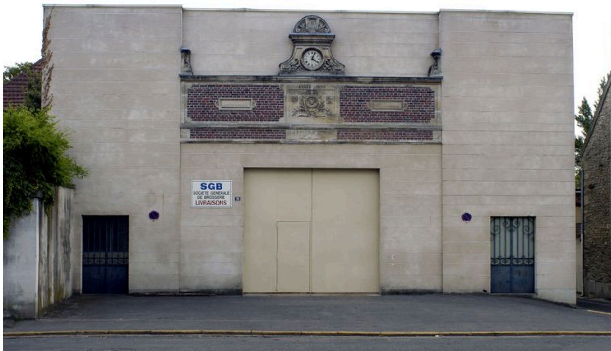
Façade sur rue du magasin industriel.
