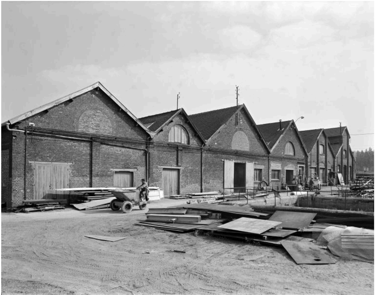
Vue extérieure des bâtiments industriels.
