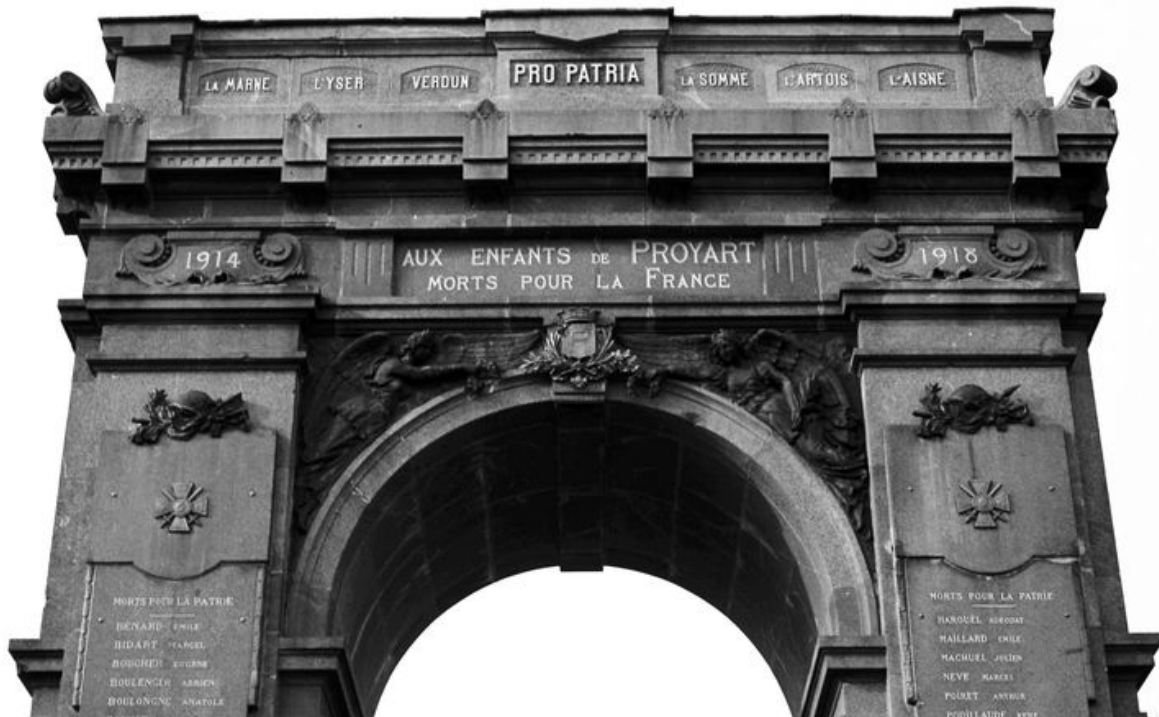
Vue de détail sur la partie supérieure du monument.
