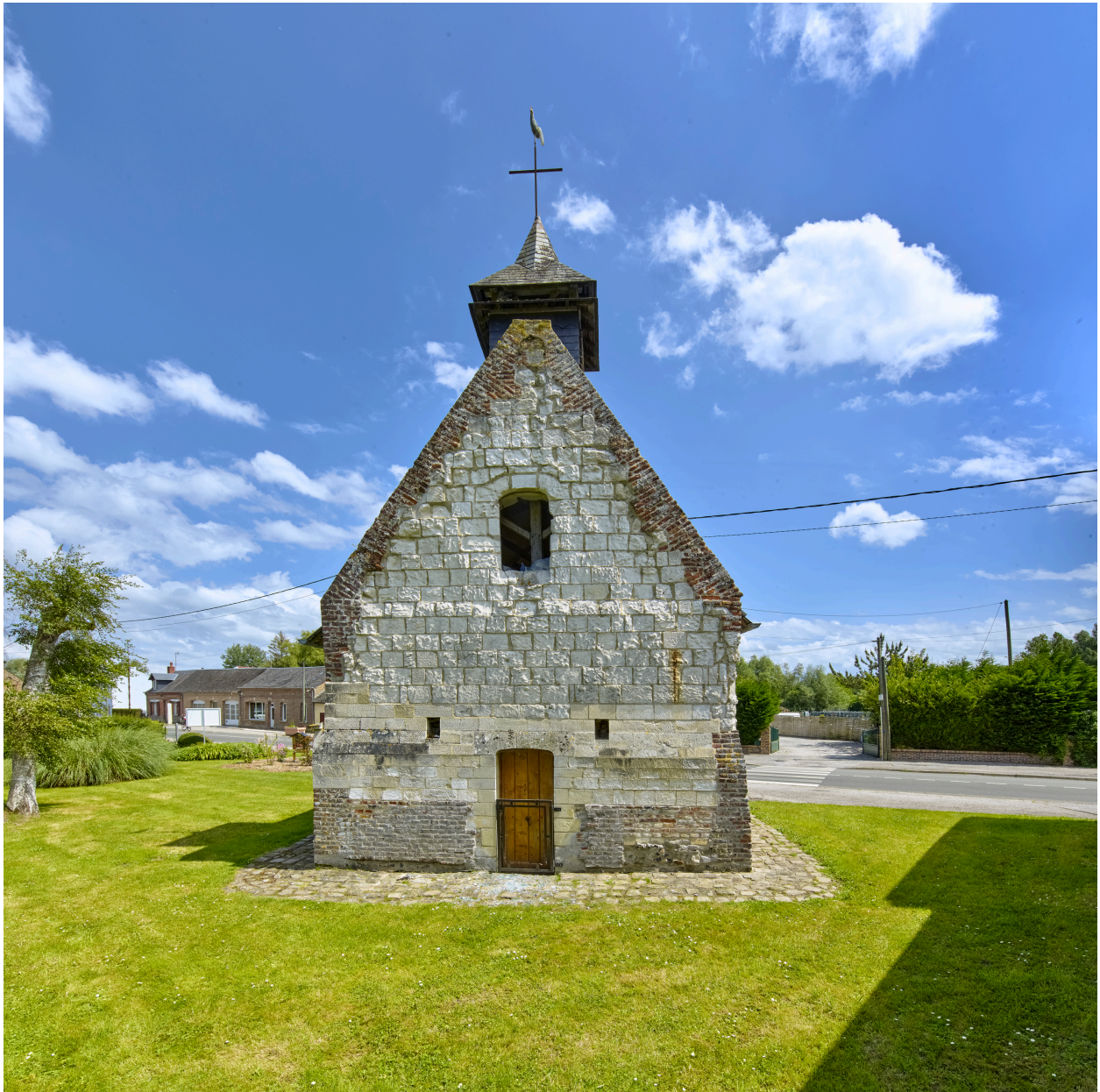
Façade ouest de la chapelle.
