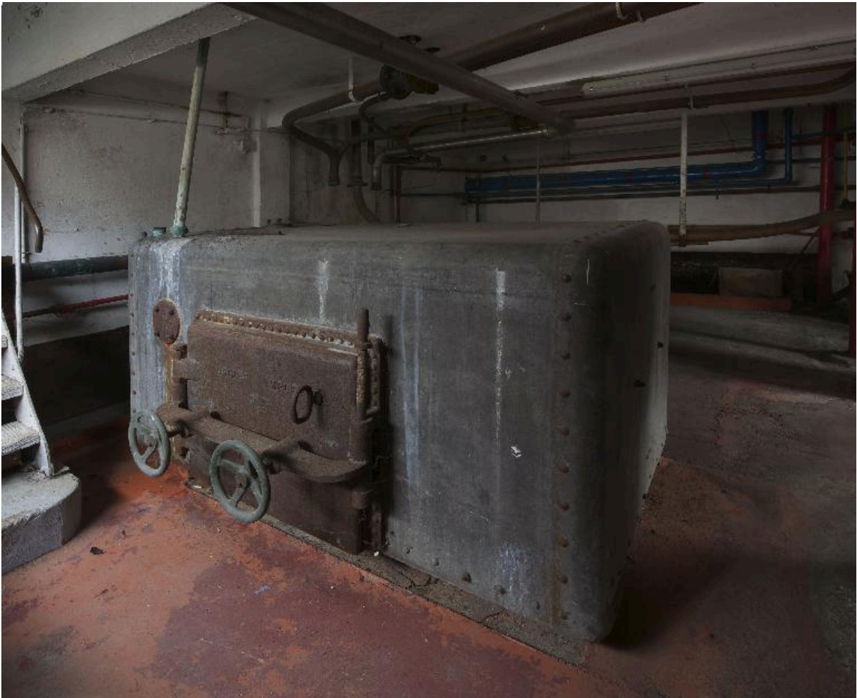
Cuve (?) au 2e niveau de la brasserie.
