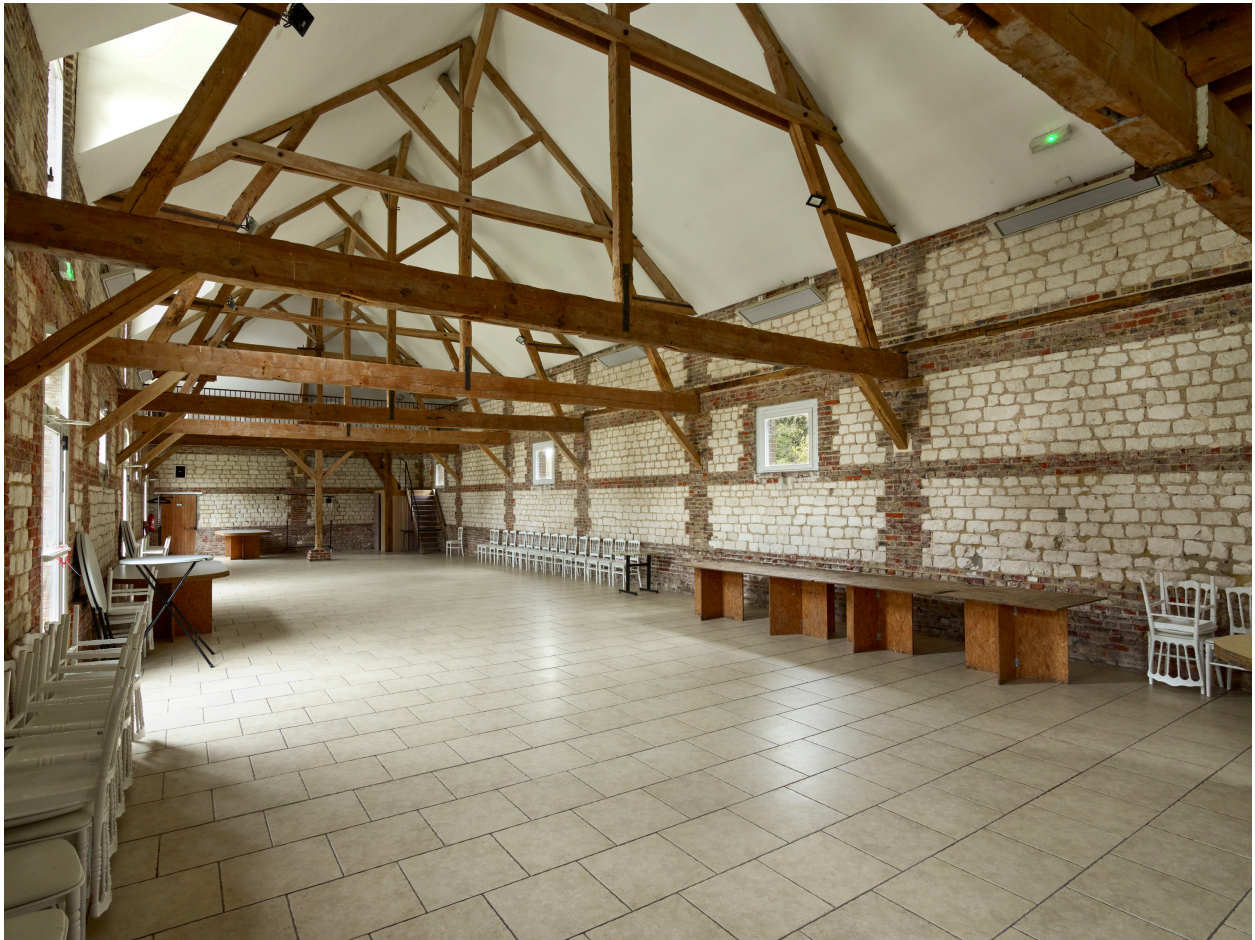
Intérieur de l'ancienne bergerie.
