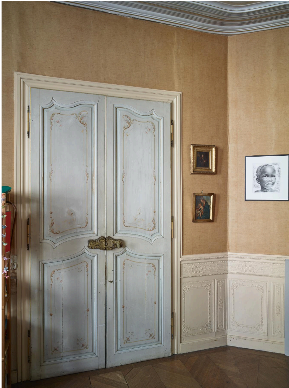
Détail du lambris du bureau et d'une des portes peintes à doubles vantaux.
