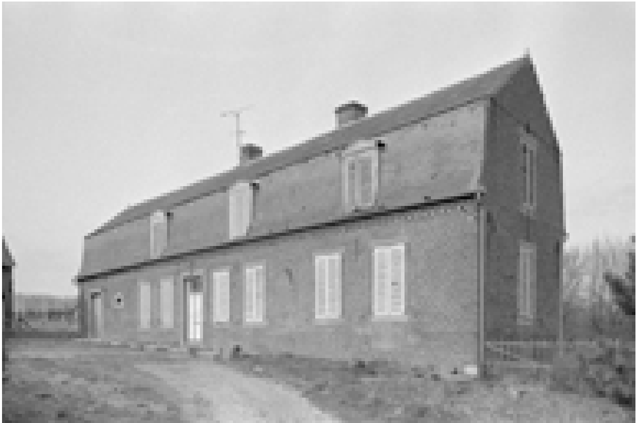
Vue générale sud du logis et de l'étable attenante.
