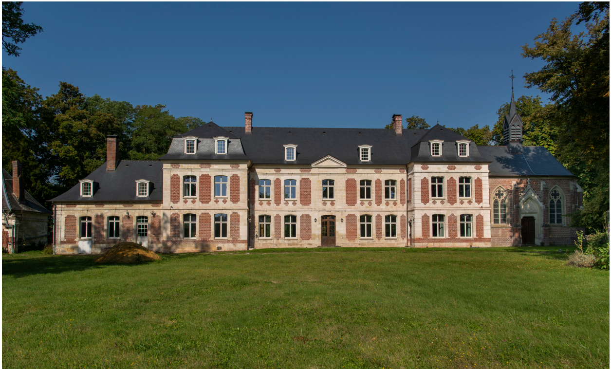
Vue depuis le sud du château et de la chapelle à droite.
