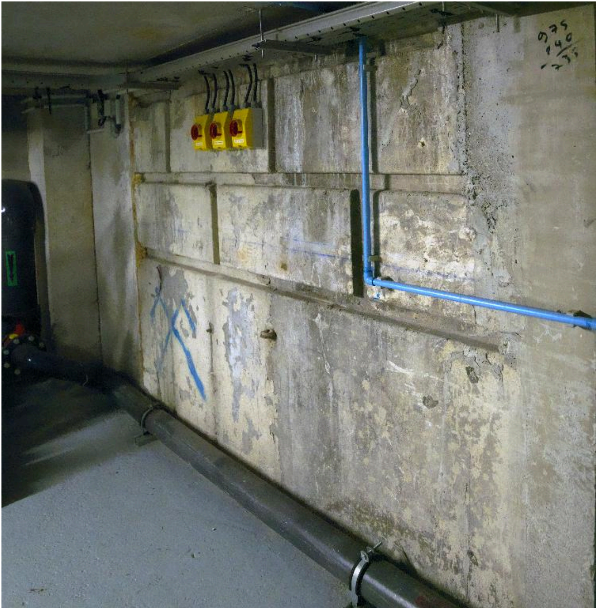
Vestiges de la structure en béton armé originelle (de 1926).
