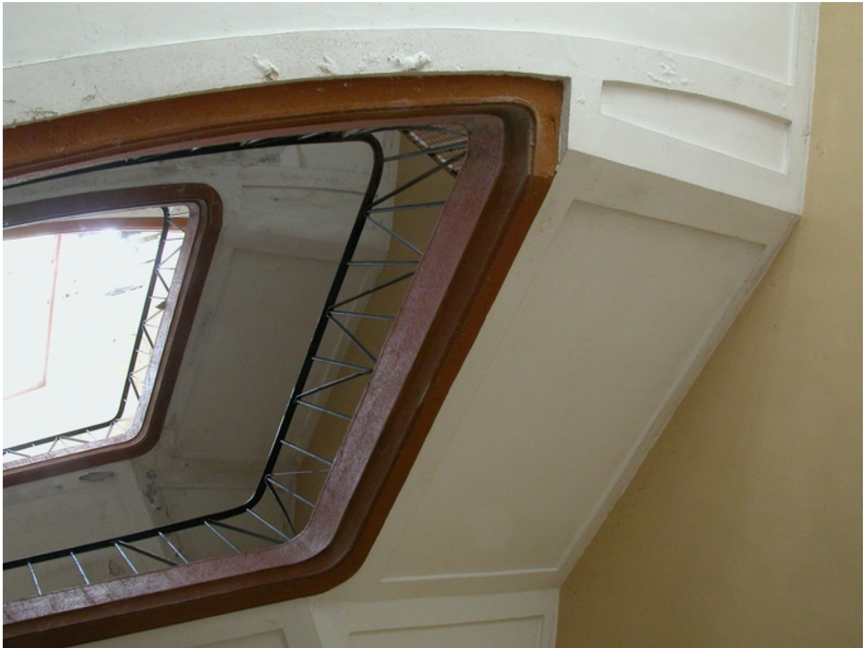
Escaliers des ateliers des années 1946-48.
