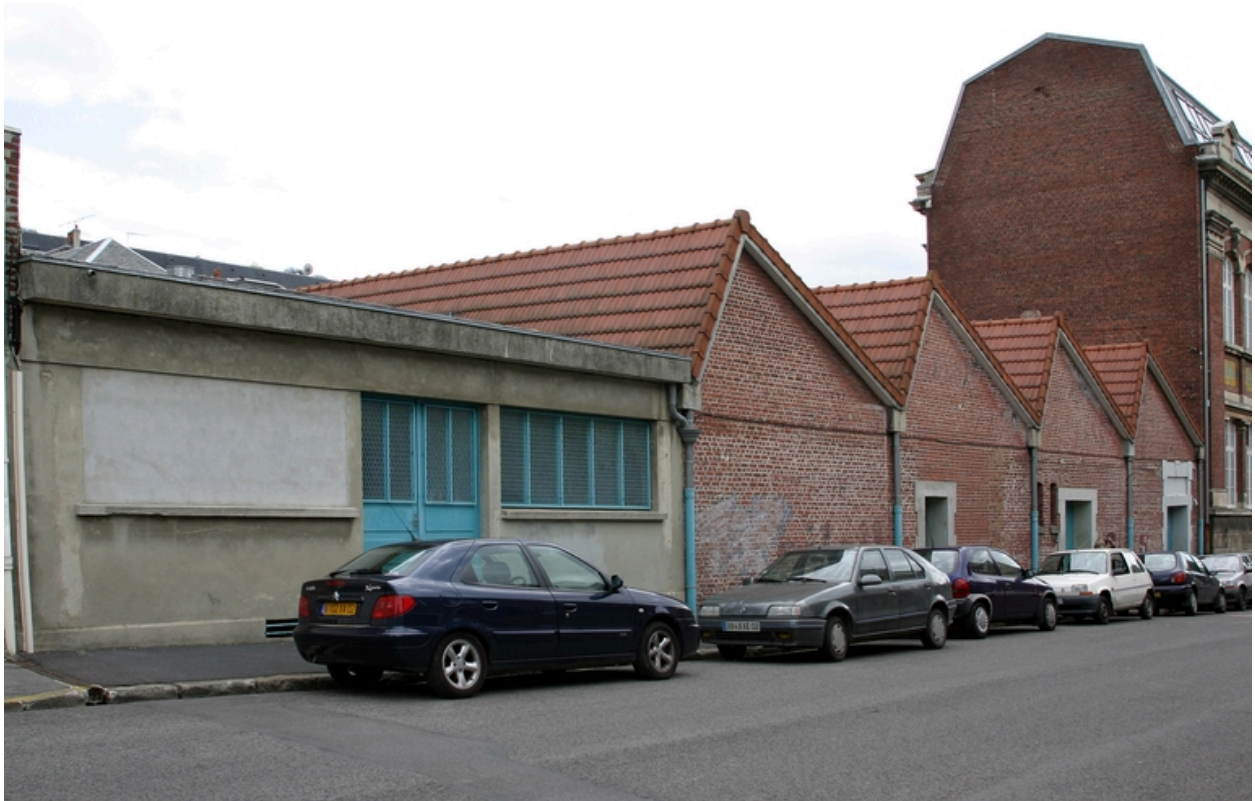
Vue des ateliers, rue Emmeré.
