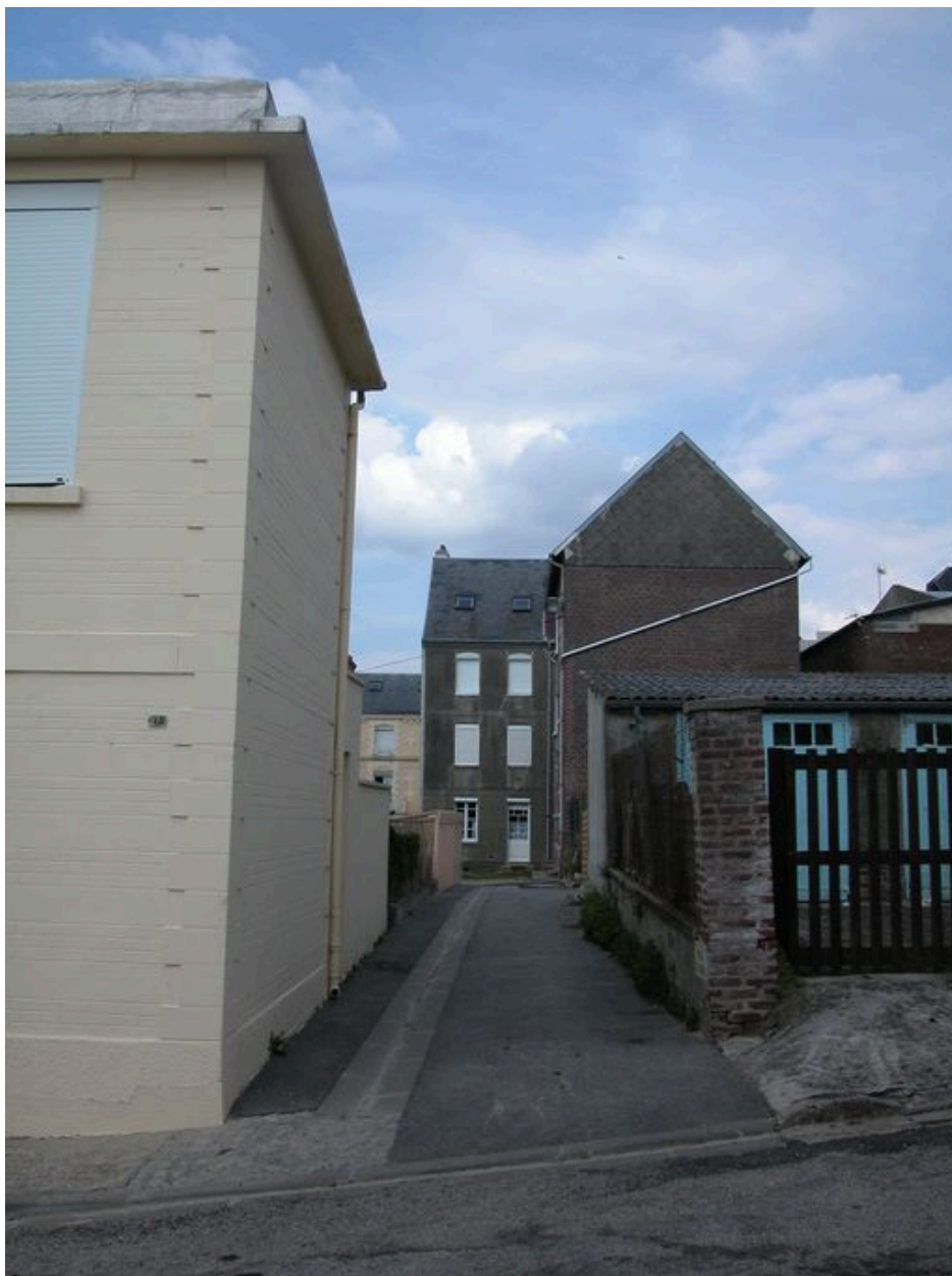
La ruelle du casino, vue depuis la rue Continental.
