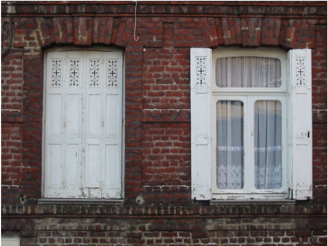
Rang nord-ouest : maison n° 31, détail, rez-de-chaussée, fenêtres garnies de volets en menuiserie ajourée.
